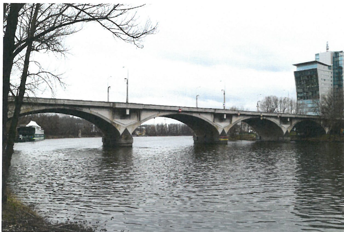
Pohled ze severu na holešovickou část překonávající Vltavu
