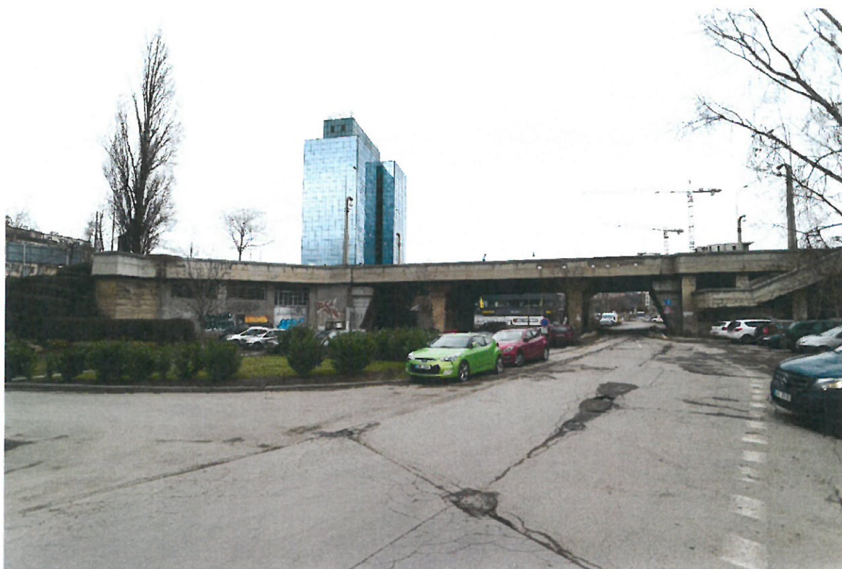
Začátek mostu na straně Holešovic, rozšířený náběh s vnitřními prostory a průjezdy s železobetonovou rámovou konstrukcí, vpravo schodiště
