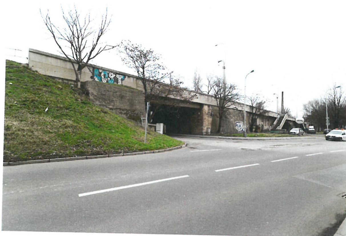
Libeňská část mostu s průjezdem
