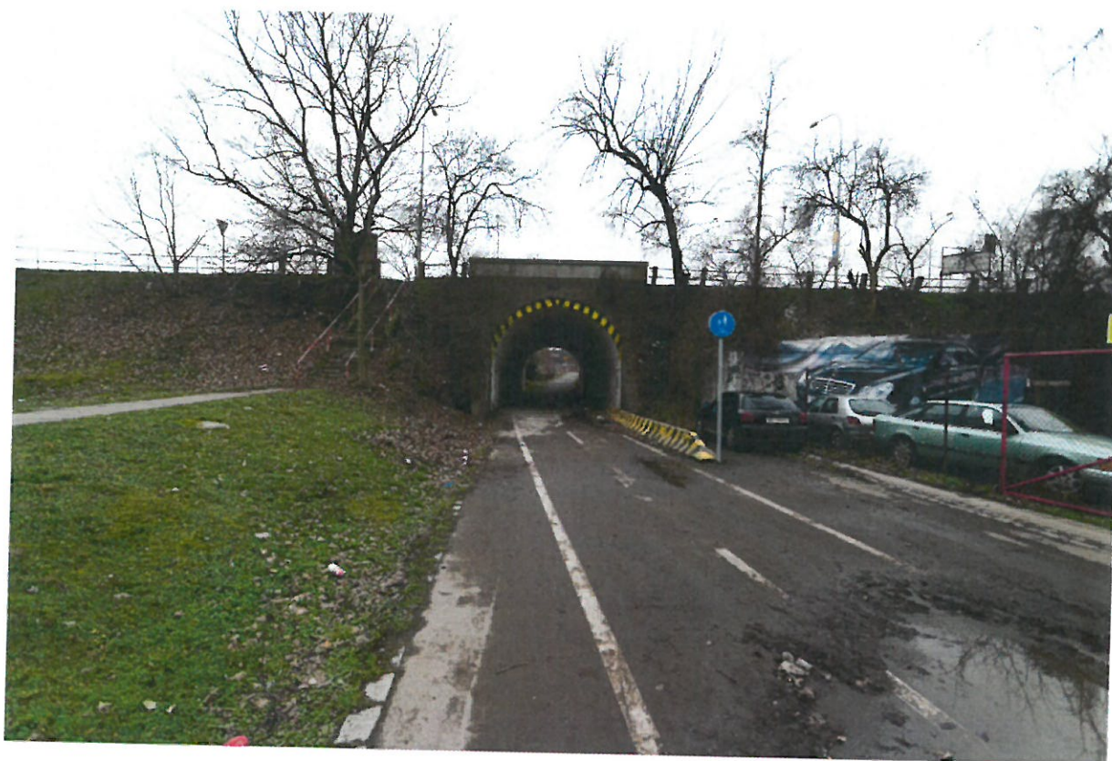
Tunel v náspu, valená betonová klenba, zábradlí shodné s ostatními částmi mostu
