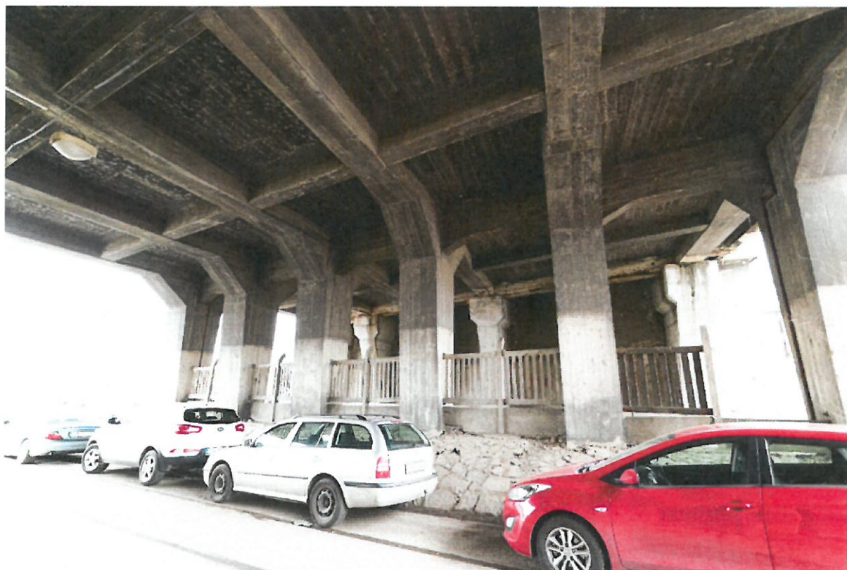
Rámová konstrukce průjezdu
