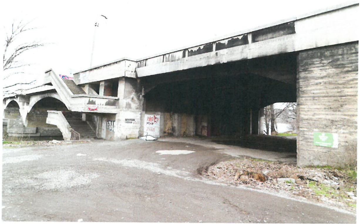
Část na břehu Libeňského ostrova se schodištěm a průjezdem
