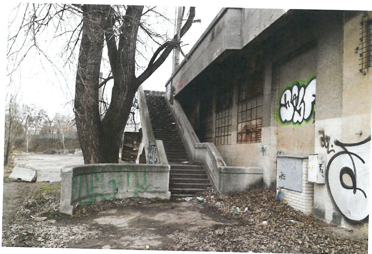
Schodiště na jižní straně Libeňské části mostu
