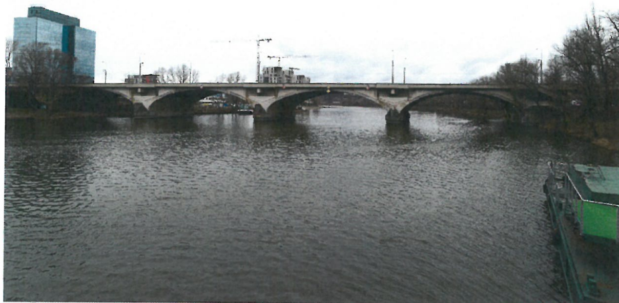
Pohled z jihu na holešovickou část překonávající Vltavu
