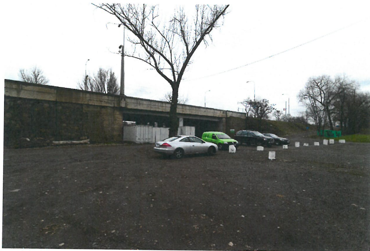
Navazující úsek s kyklopským zdívem a průjezdem opět rámové ŽB konstrukce
