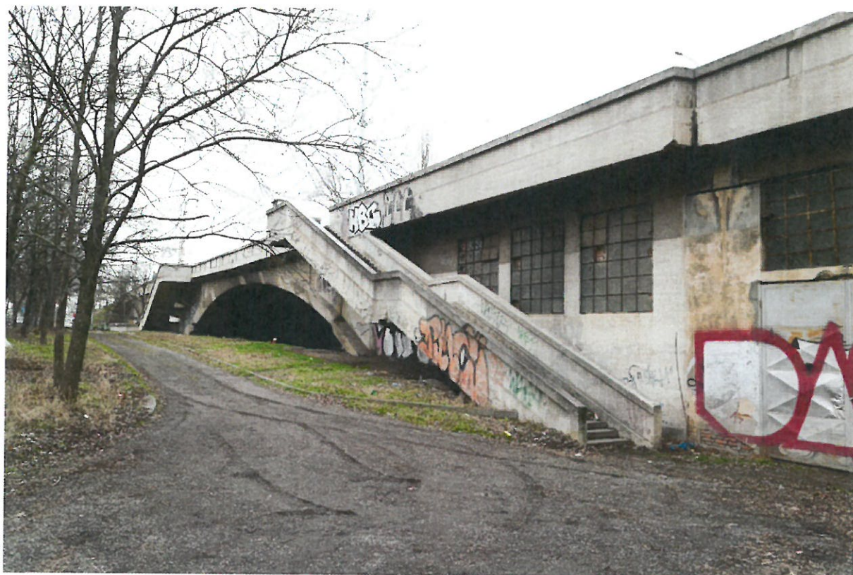
Schodiště na severní straně Libeňské části mostu
