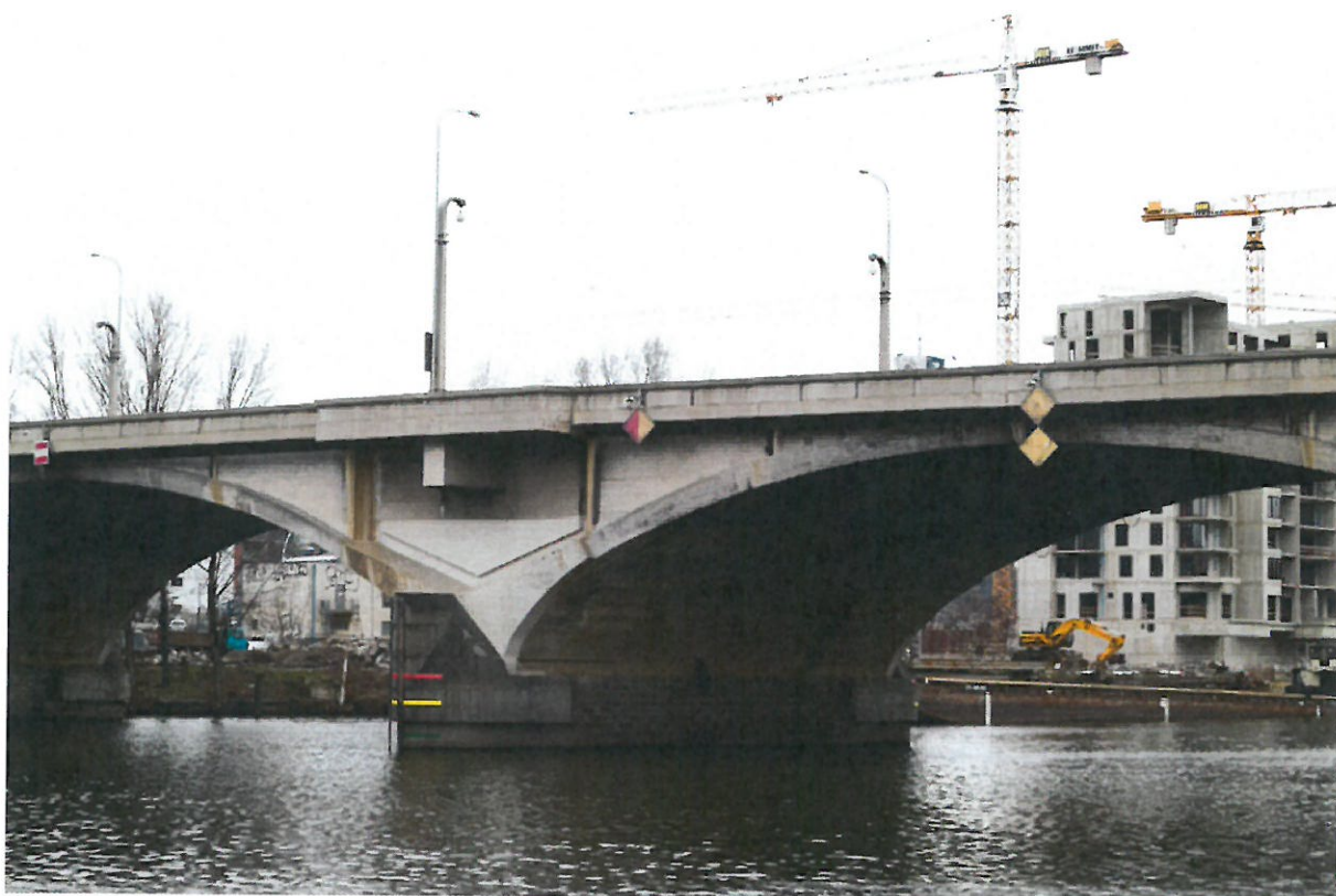
Bližší pohled na přemostění Vltavy
