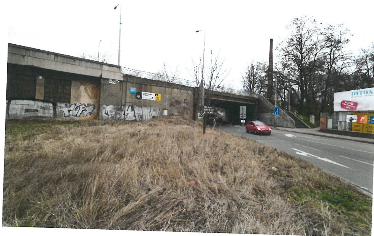
Konec původní konstrukce mostu a navazující novější průjezd Voctářovy ulice (tyčové zábradlí) a dále násep směrem na Palmovku.
