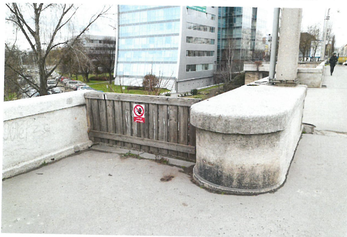
Uzavřený vstup na schodiště na straně Holešovic
