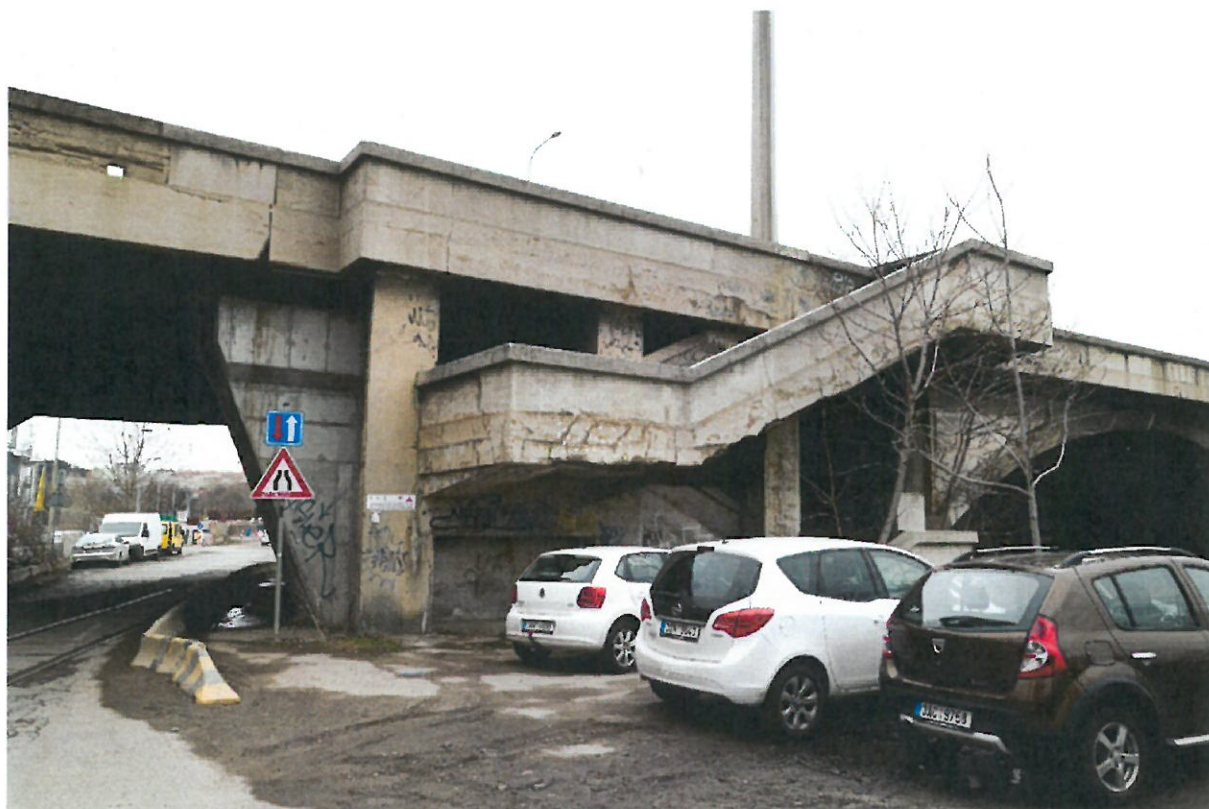
Schodiště na jižní straně Holešovické části
