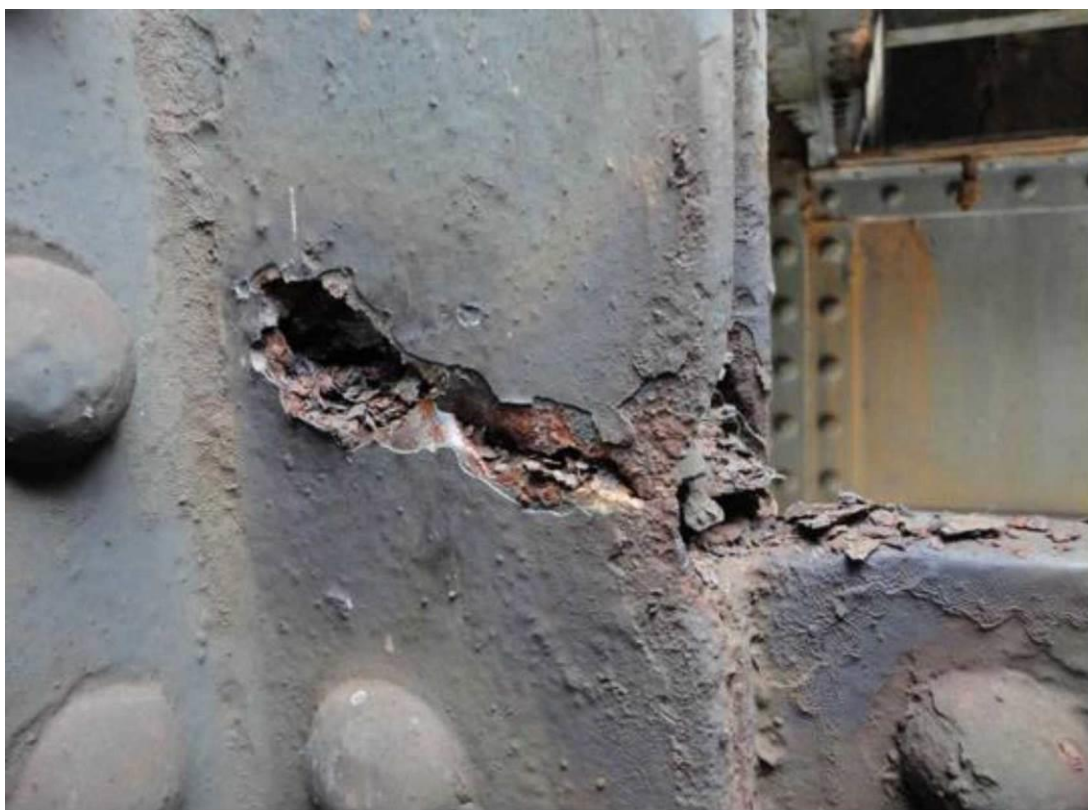
Obr. 12 Příklad (nejhorší případ) korozního poškození ve svislici (snímek 6 z prezentace Martina Vlasáka ze SUDOP PRAHA a.s. ze dne 12. prosince 2024; obdobný obrázek na snímku 25 z prezentace Iana Firtha ze dne 12. prosince 2024.)
