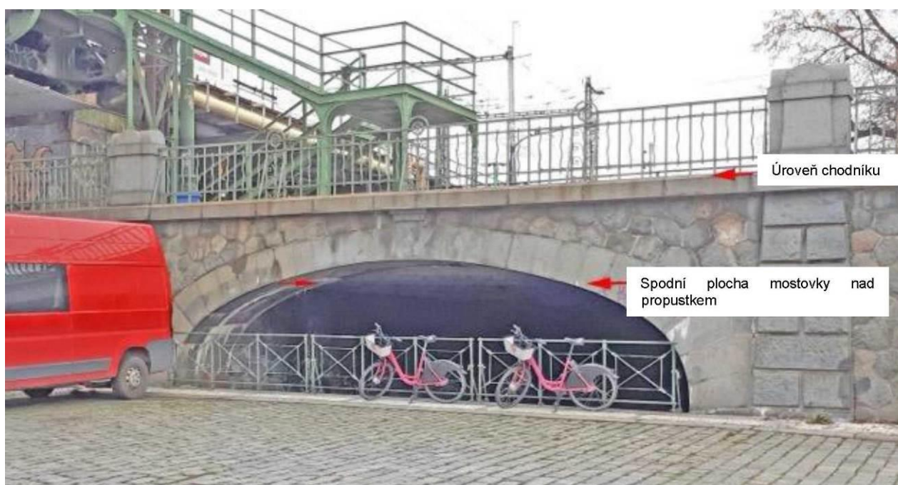
Obr. 16 Ústí propustku umožňující vtok Botiče do Vltavy (P Drury, 11. prosince 2024, s poznámkami).
