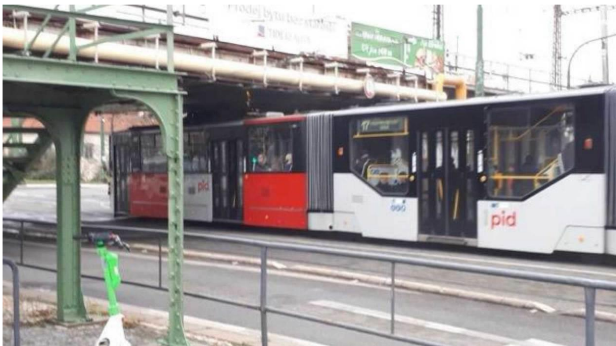
Obr. 15 Omezený průjezdný průřez (v současnosti 3,1 m) pod posledním polem viaduktu Obr. 1, 2 před příhradovým mostem 1 (P. Drury, 11. prosince 2024).
