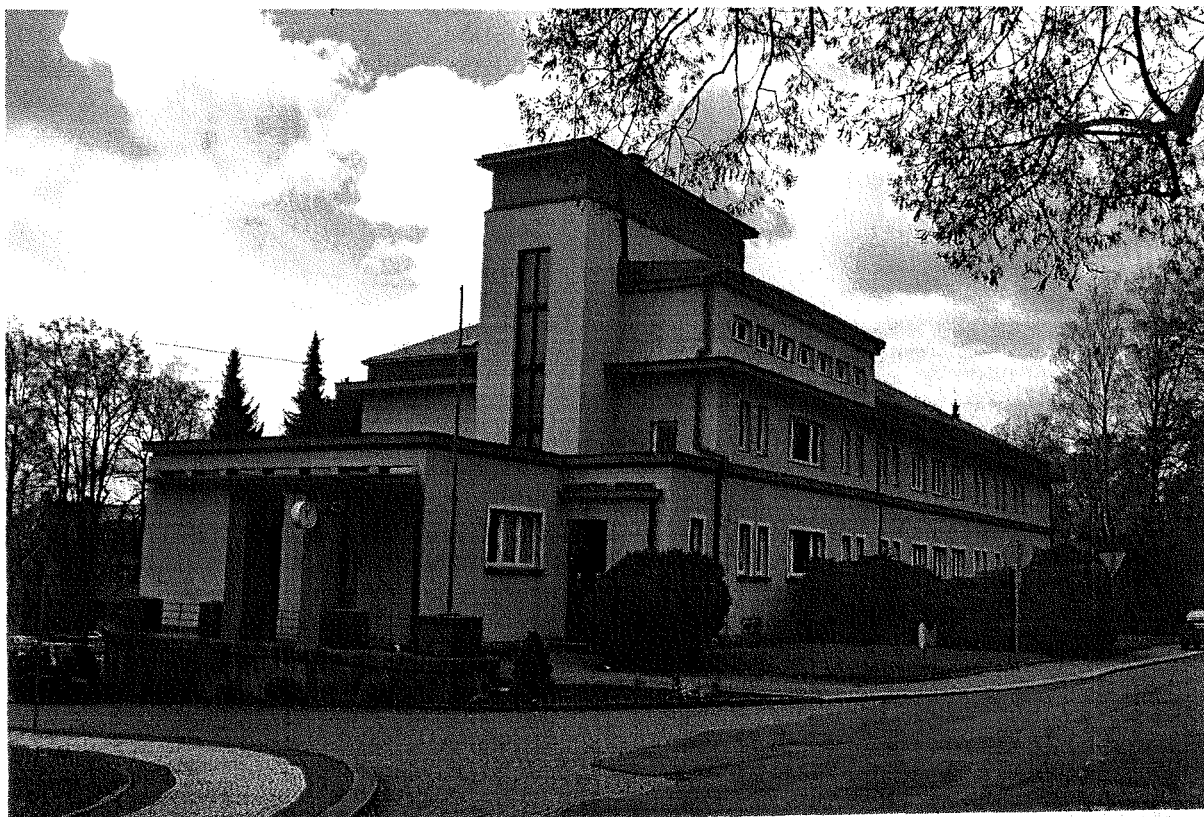
Budova ředitelství - exteriér
